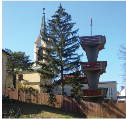
Der Feuerwehr Übungsturm, noch weithin sichtbar
