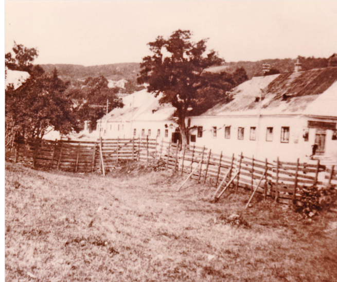
Das ehemalige Bett des Krottenbaches, heute etwa Vorgarten des Gemeindebaus
